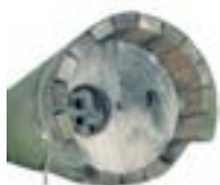
▲ Foro d'accesso con protezione contro le martore
